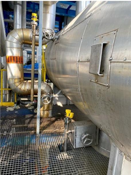
Im 3-Phasen-Separator misst beispielsweise der **VEGAFLEX 81**, ein Füllstandsensor mit geführtem Radar, die Kohlenwasserstoff-Wasser-Trennschichten. Die Daten sind nötig für die Steuerung der Wassermenge, die vom Behälter zur Kläranlage gepumpt wird. So wird der ungewollte Austritt von Kohlenwasserstoffen verhindert. Dafür erfolgt die kontinuierliche Füllstandmessung in den Böden der Kolonne.
