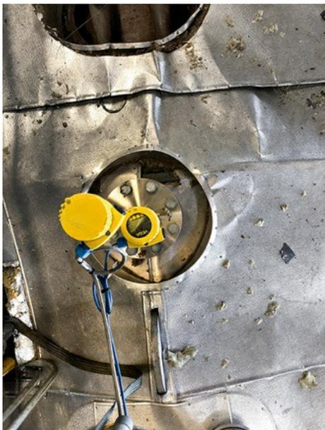
Ein massiver, auf dem Kessel installierter Kombiflansch mit Blindflanschdeckel und robustem Schraubgewinde bringt zwei der für den Prozess benötigten Messgeräte an einem Anschluss zusammen. Mit den ermittelten Werten über die aktuellen Prozesszustände schafft die Kombination Sicherheit, denn beide Messumformer bestätigen sich gegenseitig die Plausibilität ihrer Ergebnisse.
