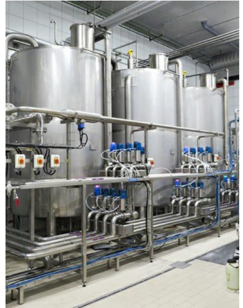
要让生产在卫生方面保持完美的状态，CIP设备不可或缺。VEGA传感器连续测量清洁剂的液位，以确保设备得到清洁和消毒。
