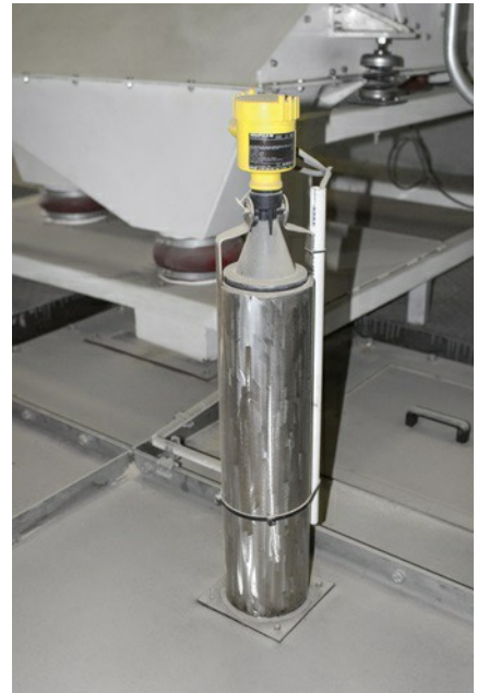
Ondanks de duidelijk kortere golfte van de VEGAPULS 69 is de radarsensor zeer ongevoelig voor aangroei.
