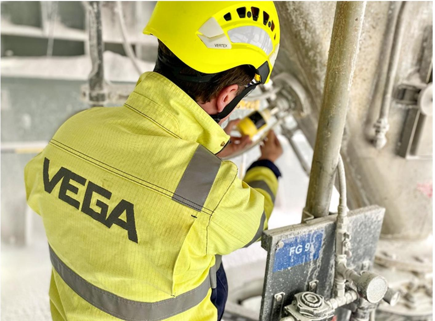
Der VEGACAP 65 misst auch unter extrem staubigen Bedingungen dauerhaft zuverlässig.
