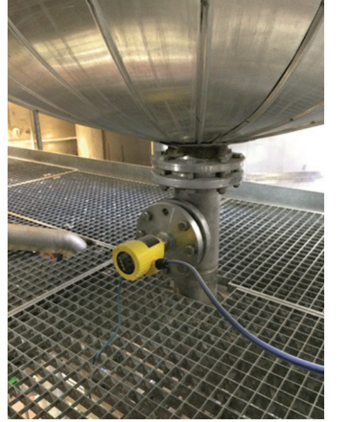
Bir damıtma tankında yapılan elektronik fark basınç ölçümünde kullanılan anabirim sensör.
