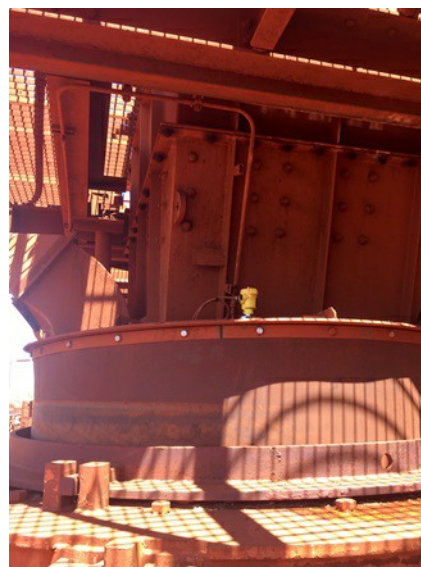
Il robusto sistema di antenna chiuso del VEGAPULS 69 non sporge nel serbatoio e grazie al principio di misura senza contatto garantisce un'elevata disponibilità dell'impianto.
