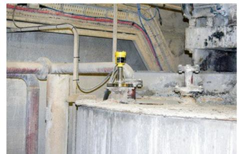
Der 80 GHz-Radarfüllstandsensoren VEGAPULS 64 von VEGA misst präzise den Füllstand am Rand des Kalkmilch-Mischbehälters.
