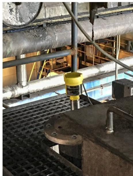
Il test del VEGAPULS 64 si è svolto senza alcun problema, anche grazie alla possibilità di montare lo strumento di misura direttamente sul tronchetto preesistente.
