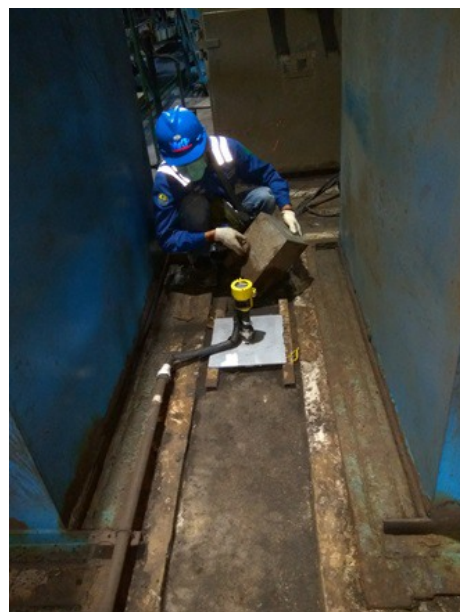
Die Linsenantenne des Füllstandssensors ist unempfindlich gegen Ablagerungen und Schmutz.
