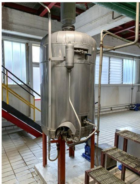
Asimismo, había otro problema en la aplicación que provocaba imprecisiones en la medición, ya que se seguían acumulando pequeños cristales en los racores roscados de los tubos capilares. En resumen, la medición de nivel era inestable y, a menudo, imprecisa.
