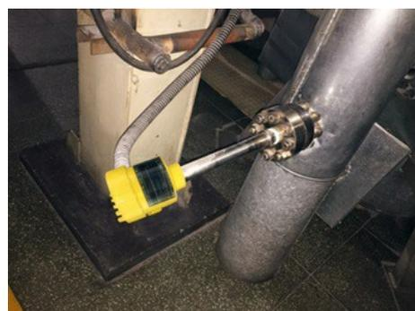
Der Vibrationsgrenzschalter VEGASWING 66 arbeitet zuverlässig und trotz den schwierigen Umgebungsbedingungen im Wärmekraftwerk.
