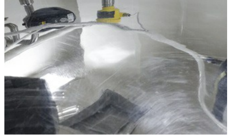
De radarsensor VEGAPULS 64 is ideaal voor metingen tot op de tankbodem.
