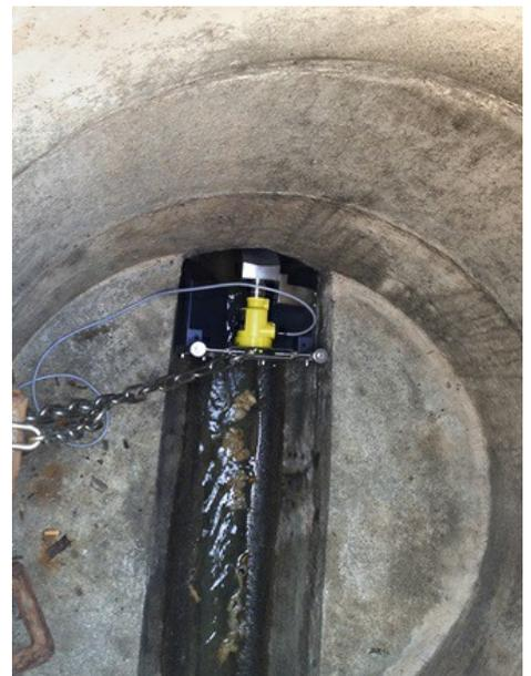
Dank der integrierten Spannvorrichtung ist die Montage einfach. Zudem wird der Querschnitt dabei nur gering vermindert.
