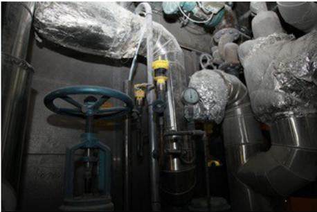
Zur weiteren Steigerung des Trockengehalts wird das Papier durch die Trockenpartie mit dampfbeheizten Trockenzylindern geführt. Das entstehende Kondensat muss mittels Differenzdruck aus dem Trockenzylinder entfernt werden. Bisher wurden die Druck- und Differenzdruckmessungen über Kondensat gefüllte Messleitungen an den Prozess angeschlossen. Fehlerhafte Kondensatvorlagen führten immer wieder zu Fehlmessungen.
