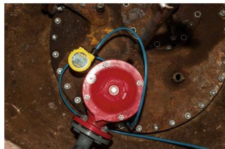
Kammer eines unterirdischen Lösemittelanks mit Radarsensor VEGAPULS 64.
