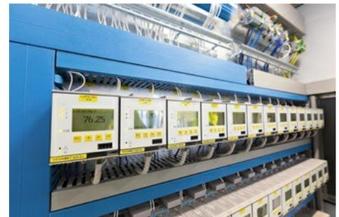
Steuerschrank mit Auswertgeräten VEGAMET 624 für das unterirdische Lösemittelager.
