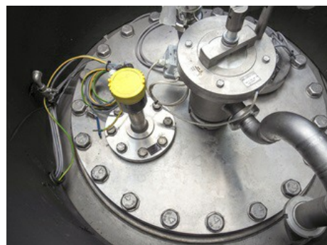
De radarniveausensor VEGAPULS 64 zorgt voor de inhoudsmeting.
